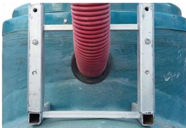
Fig. 1 Racordarea tubului corugat la gura de vizitare
